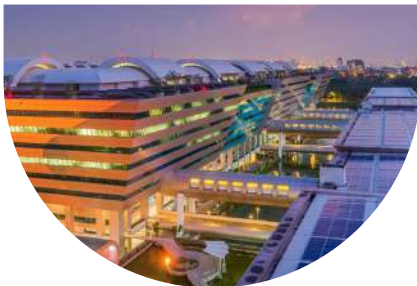
อาคารราชบุรีดิเรกฤทธิ์ (อาคาร A) 150,000 ตารางเมตร มี 11 หน่วยงาน
