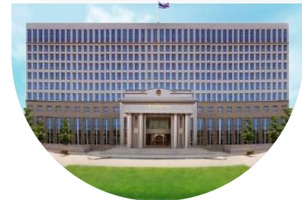
อาคารศาลปกครอง 56,540 ตารางเมตร มี 1 หน่วยงาน
